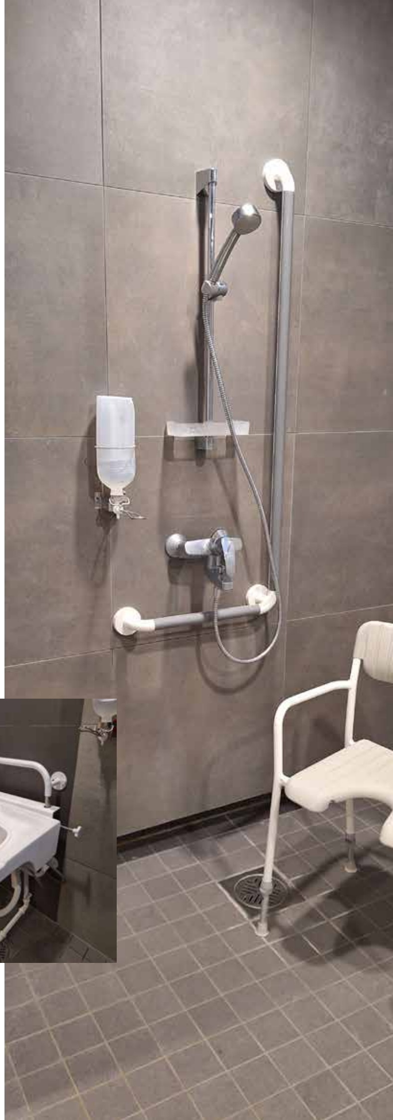
WC-tiloissa lavuaarin korkeutta pystyy säätämään.
