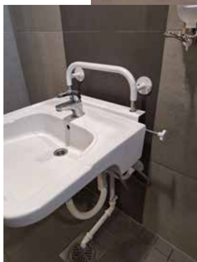
WC-tiloissa lavuaarin korkeutta pystyy säätämään.
